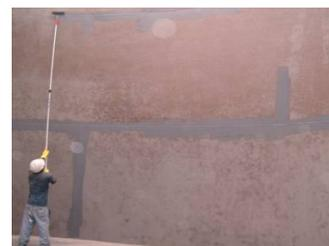
L' **ALIPOX** est un système époxy spécifique sans solvant à 100% d'extrait sec. Ce système de nouvelle génération remplace les anciens systèmes à base d'amines aromatiques qui ne répondent plus aux exigences réglementaires de l'Union Européenne.
